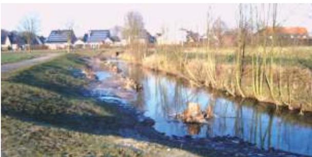
Im weiteren Verlauf des Baches bis zum Abzweig der Umflut und entlang der Umflut bis zur anderen Dorfseite, wo die Umflut wieder in den Kleuterbach mündet, wurden die Böschungen auf Teillängen abgeflacht und zurückgenommen, sodass im Bereich der Grabensohle einzelne Sandbänke und Inseln entstehen, die je nach Höhe des Wasserstandes trocken liegen oder überspült sind. Durch den Wasserfluss werden die Sandbänke ihre Lage und Form ständig verändern. Für den Hochwasser-
